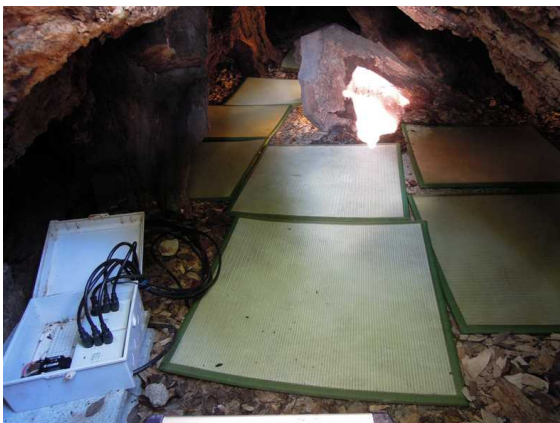
그림 3-29_공동내부 인공건조 상태
