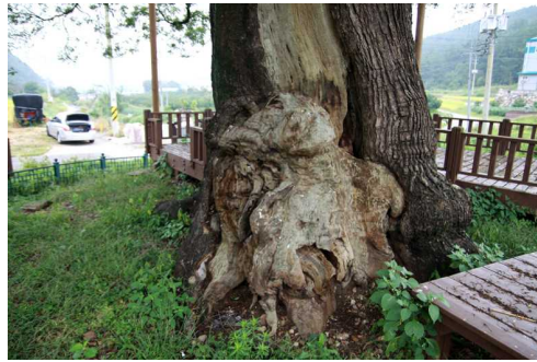
그림 3-45_공동부 충전물 제거 후 노출시킨 상태 1
