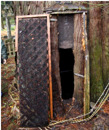
그림 3-27_공동부 보호창 설치
