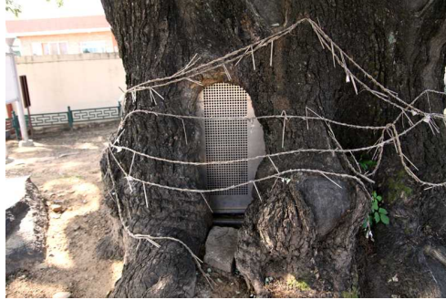
그림 3-38_공동부 보호창 설치
