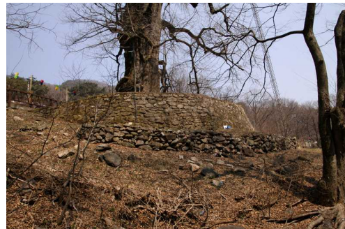
그림 3-11_석축설치에 의한 복토 전경
