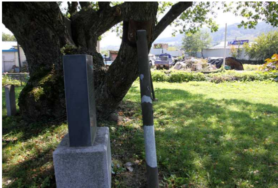
그림 3-16_부적절한 지지대 철관 표면처리 탈락
